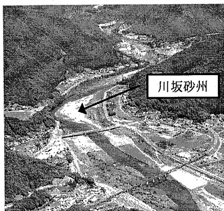
図-1 川坂砂州付近の状況（宮崎県資料より）
