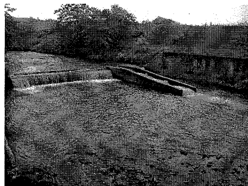
写真-1 堰に設置された張り出し型魚道
