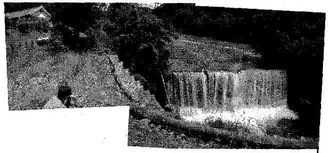
写真-2 1号砂防ダムの状況
