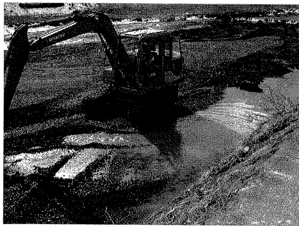
写真-4 河床材料状況（スリット施工前2003. 2. 5）
