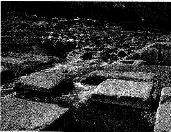
写真-3 スリット部を下流から望む
