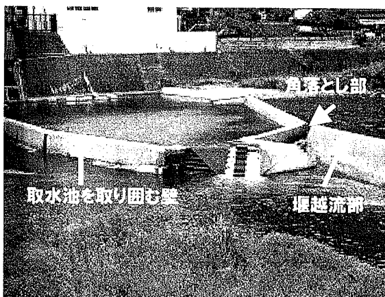
写真-3 魚道整備後の状況(2005 年 9 月)
