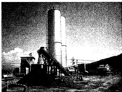
写真-2. 改良状況
