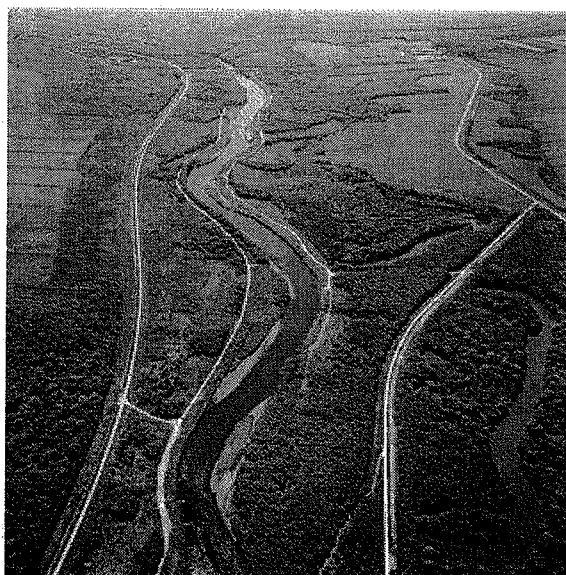
図-1 標津川下流部と周辺に残る旧河道
