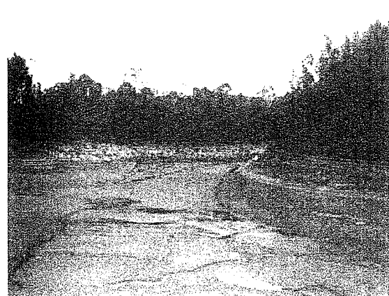
図-3(d) ため池の埋立(図-2 中の D 池)
