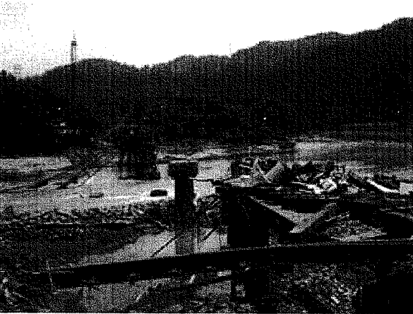
写真-2 第1鉄橋付近の被災状況
