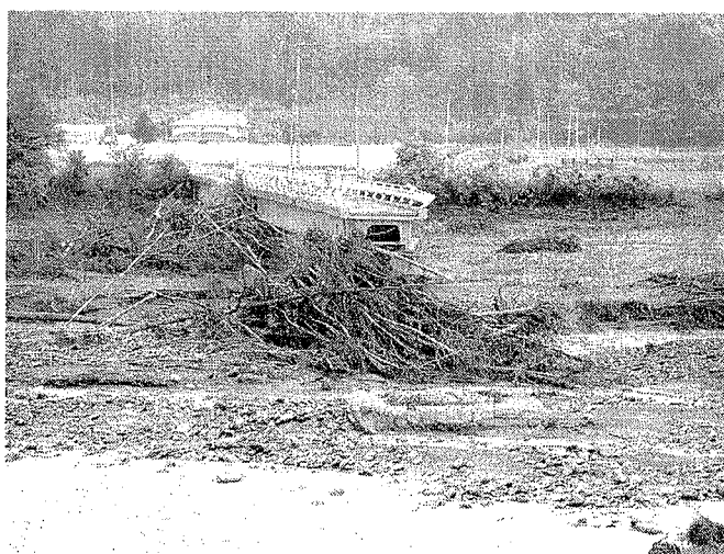
写真－3 アブシトエナイ橋の被災状況
