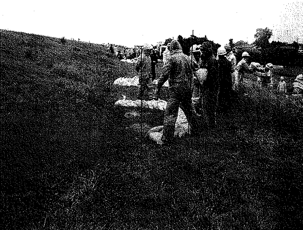
写真-2 堤内側小段からの漏水箇所の水防活動状況
