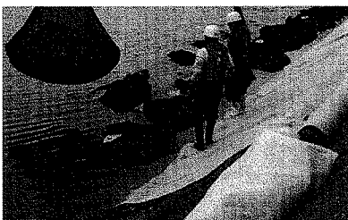
写真-3 袋詰玉石工による護岸補修事例
