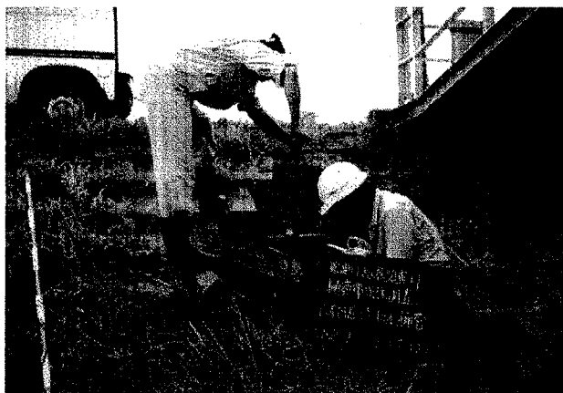
写真-5 老朽樋管からの吸出による堤防陥没事例
