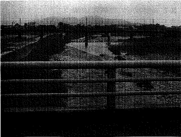
写真-6 土器川における植生の繁茂と河床上昇状況 3) 足羽川の南に位置する岐阜県の板取川では、河床が砂
