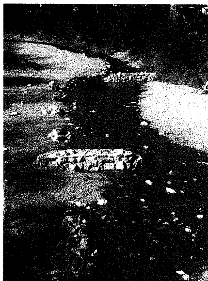
写真-2 実験工事対象区間（水制設置直後）
