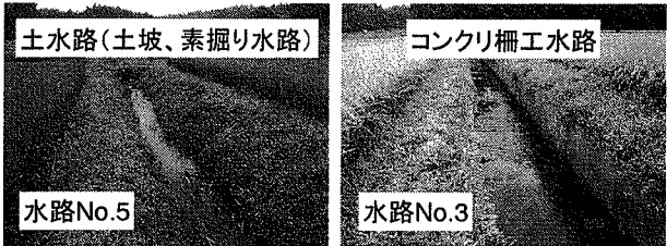
写真－1 圃場未整備地区の土水路 (左) と整備地区のコンクリート柵工水路 (右)
