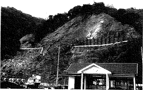
図-8 道路法面崩壊現場 (F 県, 2002 年 3 月)
