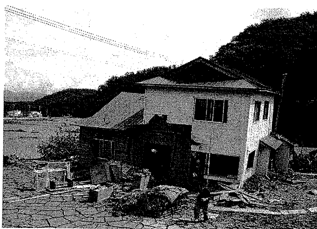
写真-6 比宇川合流点付近D地点の民家の被災状況 の流向を写真-9に示す。
