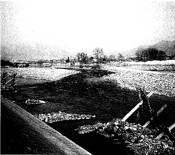
写真-4 H11. 8出水後の被災の様子
