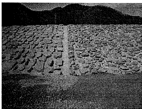
写真-3 開発された甲州流プレキャスト石張り護岸
