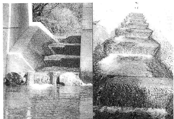
写真-3 スリット内に設置された台形断面プール式階段魚道
