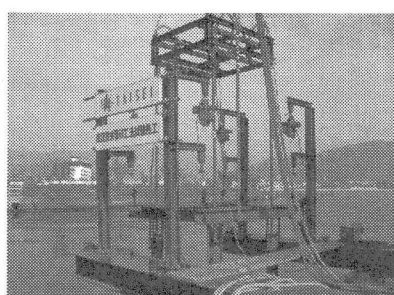
写真-6 ガイド管およびジェット管
