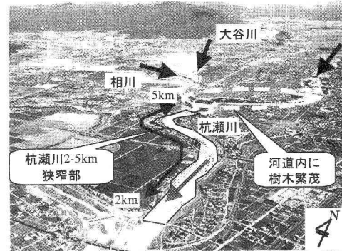
図-13 高瀬地点(左下)から上流を望む(㈱パスコ提供)
