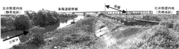
図-7 洗堰の様子
