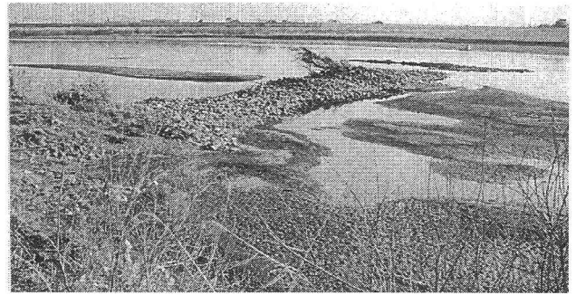
写真－４ 旧水制の詰石が水制状に機能して上下流に土砂堆積など変化に富んだ水辺の状況(134km) (2001.2)
