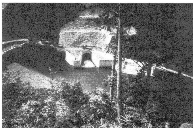
写真-1 転流工呑み口部の状況
