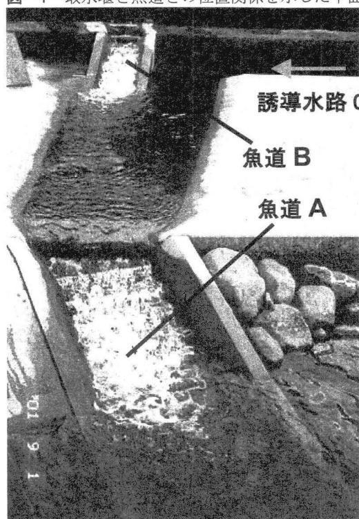
写真-1 取水堰に設置された魚道
