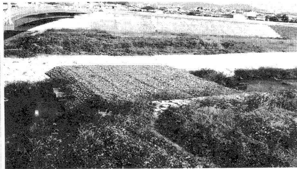
写真-2 復旧された低水路部の二の荒手堰堤
