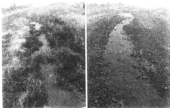
図－5 改修前、改修後の様子
