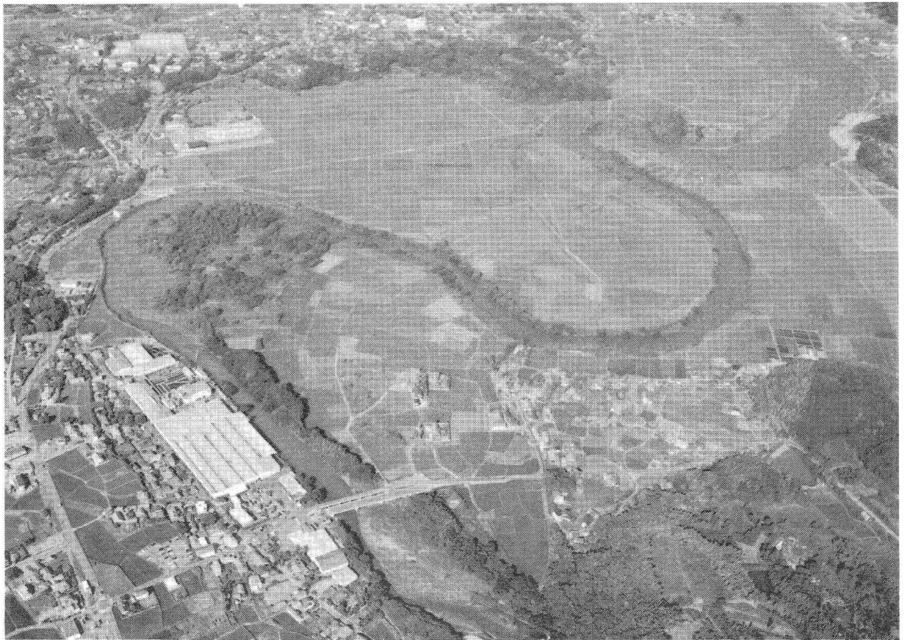
写真-1 改修工事開始直前の八坂川の空中写真 (1995年7月撮影)
