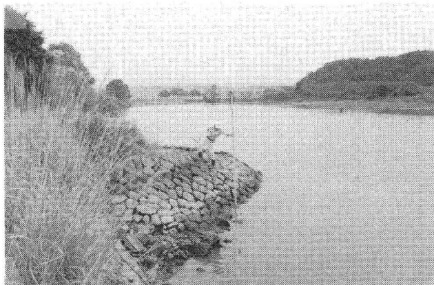
写真-2 蛇行部最下流に位置する水制①を下流側から望む（2000年7月23日撮影）
