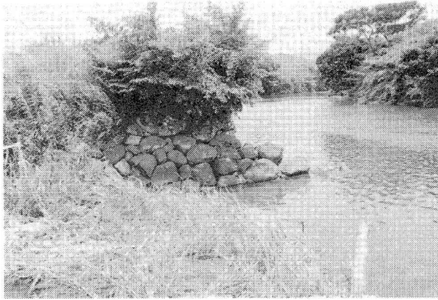
写真-5 水制⑥を下流側から望む
