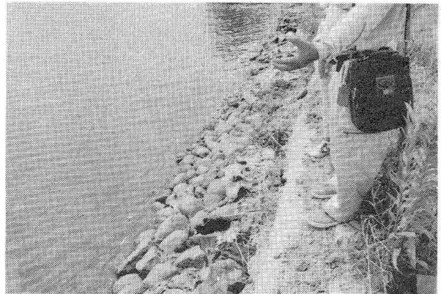
写真-7 湾曲部最下流、丸山の対岸に存在する石積護岸(図-1のA)
