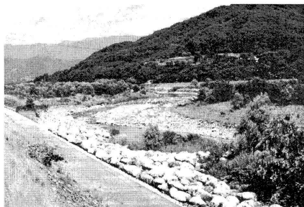
写真-4 滞筋の固定化
