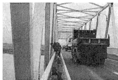
図-21 石狩大橋の観測状況
