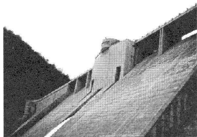
写真-2 ダム本体を主対象とする景観
