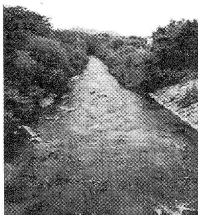
写真-3 改修区間
