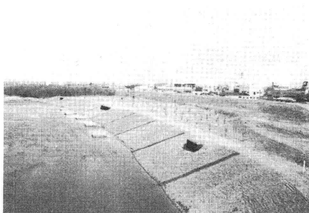
写真-1 施工直後の全景
