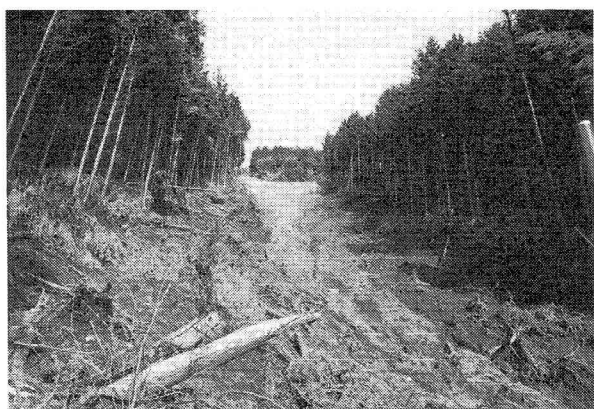
写真一2 上矢作町阿寺の斜面崩壊中間部
