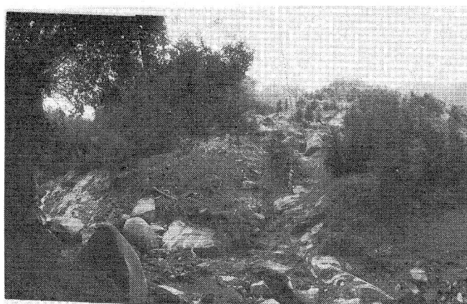
写真一9 根羽村小戸名の斜面崩壊(地上写真) 2)
