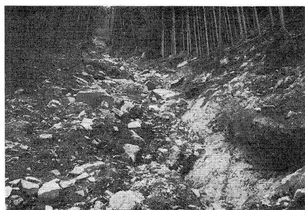
写真一6 上矢作町達原の斜面崩壊上部
