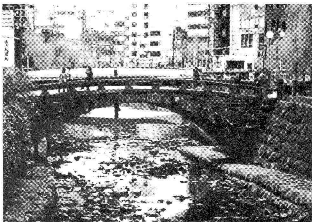
図-5 偏平で渡りやすいが断面阻害率は高く、もろいといわれる。図は袋町橋
