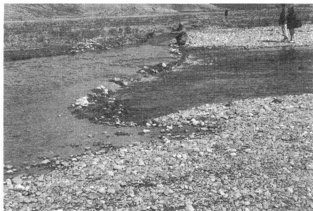
写真-3 ケカ川、玉石による導流堤
