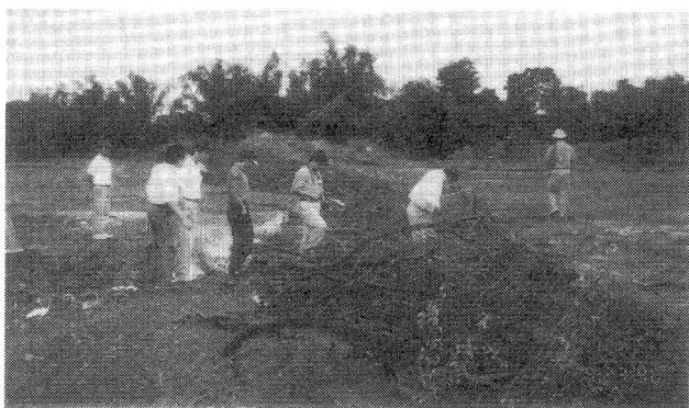
写真-1 ビライ川、粗朶による導流堤
