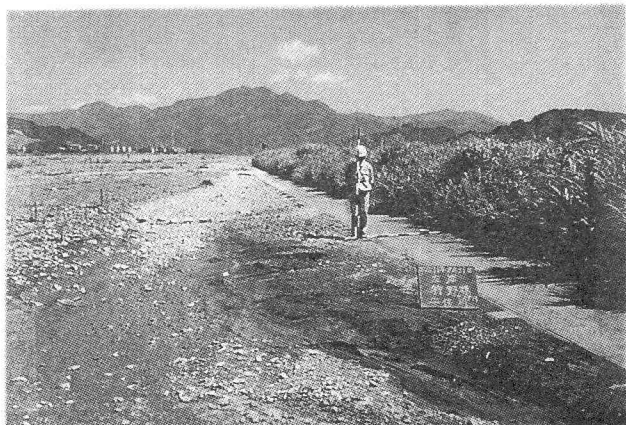
写真-1 安倍川9.25km左岸の低水路と高水敷の境界の状況
