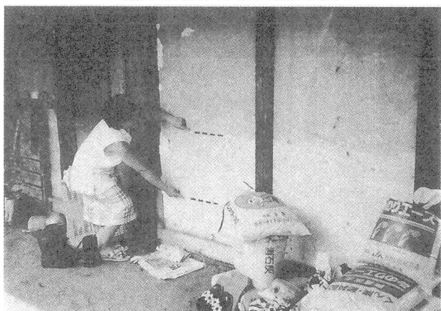
写真-2 大左右区の工藤啓氏宅の土蔵について水位痕跡 上部は1997年洪水、下部は1976年洪水時の水位痕跡
