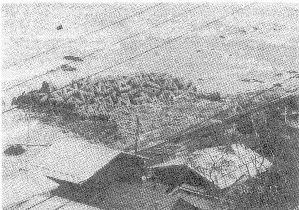
写真-2 2号離岸堤背後における流木の堆積状況
