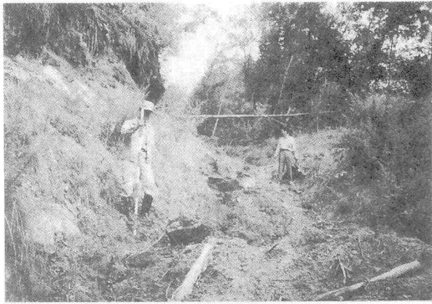
写真-8 右支川のうぐい滝流域での国有林伐採のための作業道の入口
