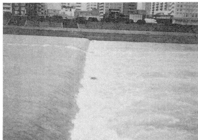
写真-3 5号床止工における実験
