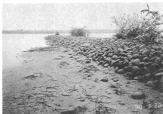
写真-2 ケレップ水制 堆積が上流に延伸し、パターンMに対応する。
