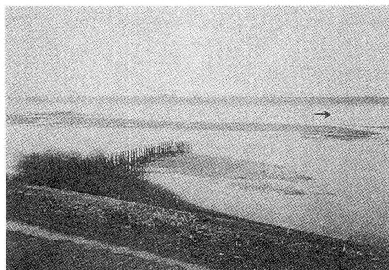
写真-3 杭出し水制 堆積が下流に延伸し、パターンOに対応する。
