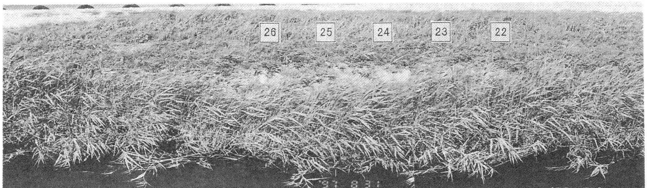
写真-3 ヨシ原河岸の崩落状況
