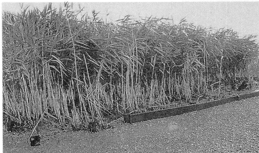
写真-3 ヨシが成長したところで波浪対策工を撤去したところ
