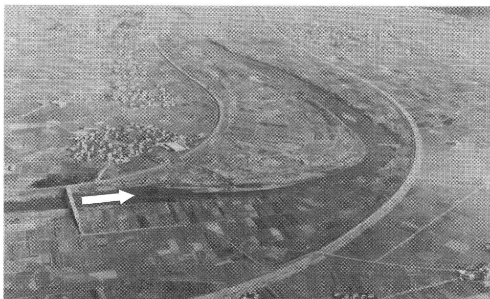
写真-1 施工前 (1984年11月撮影)
