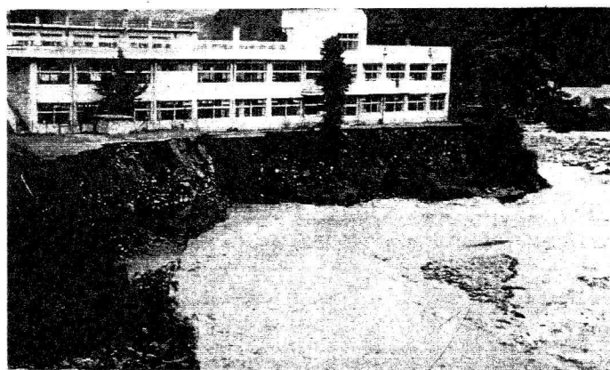
写真7 河岸侵食・拡幅（新井市除戸）
