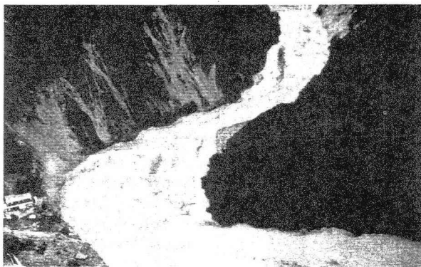
写真3 姫川蒲原温泉付近の河岸山腹崩壊
