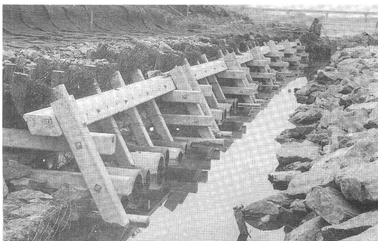
写真-2 平成5年度施工箇所（施工中の改良事例）
