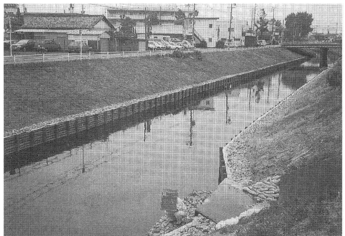
写真3-2 低水護岸に木柵工を採用しているが杭間に隙間が全くない。また、水際線は極めて単調になっている。
