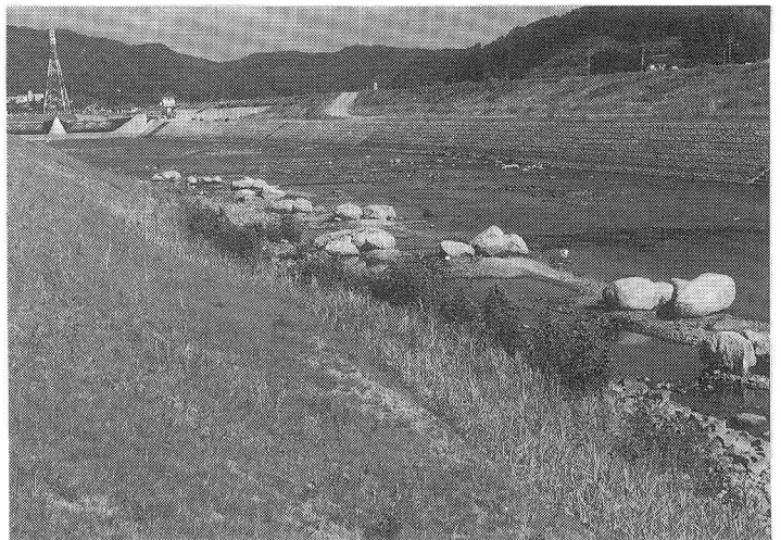
写真4-1 松浦川水系厳木川（河床勾配1/350、計画高水流量1200m 3 /s） 透水性を確保した法枠ブロック護岸を覆土、種子吹付。 植生繊維のロールとマットで水際を保護しツルヨシを植栽。 根固工には下部にブロック、上部に捨石を使用。巨石 の配置により小水域を形成。（写真は施工後約半年。）
