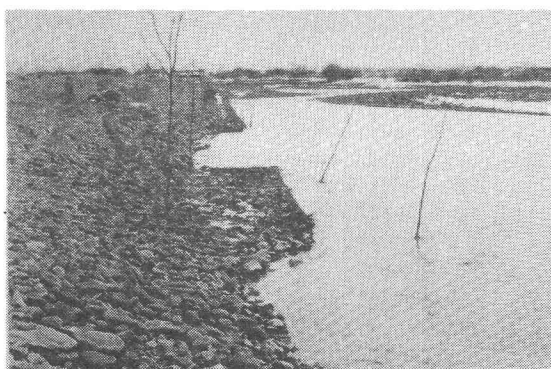
写真-19 木工沈床工下流部～瀬と淵の形成
