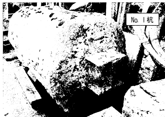
写真-4 改良体・H形鋼芯材状況
