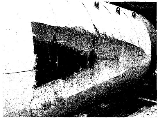
写真-12 切削完了後の状況（ケース2）
